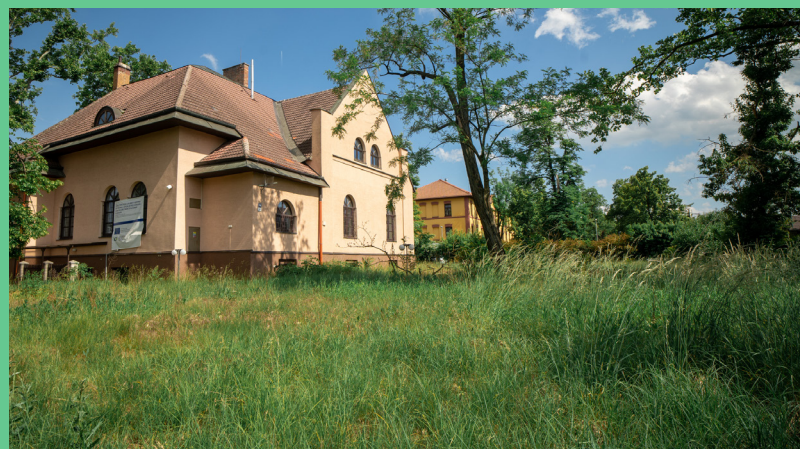
Zakoupená budova před rekonstrukcí
